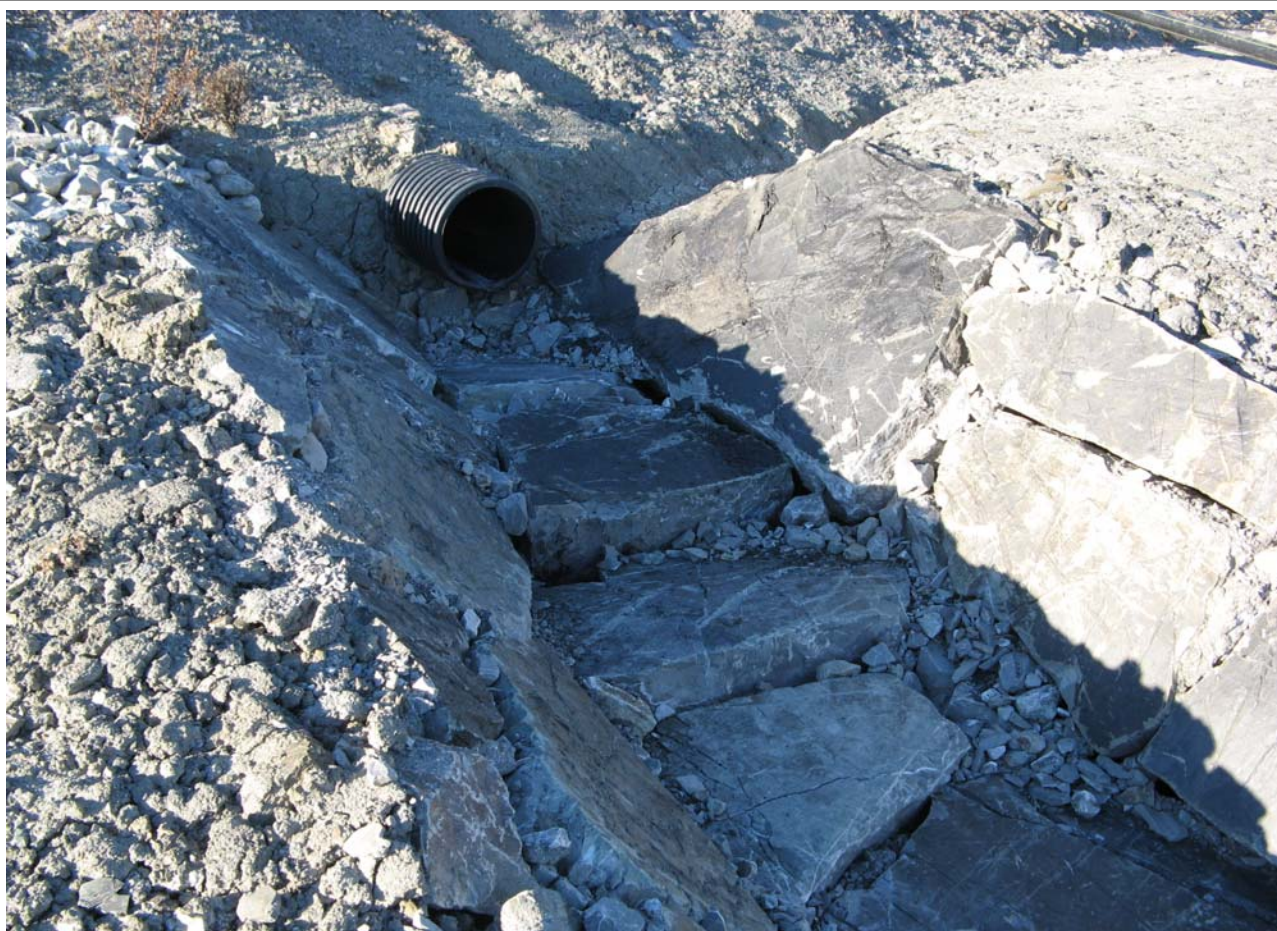
Foto 16 e 17: Particolari della realizzazione dei fossi di scolo principali, con foderatura antierosione del fondo in sasso – fosso posto al confine tra vasca 9down e vasca 7
