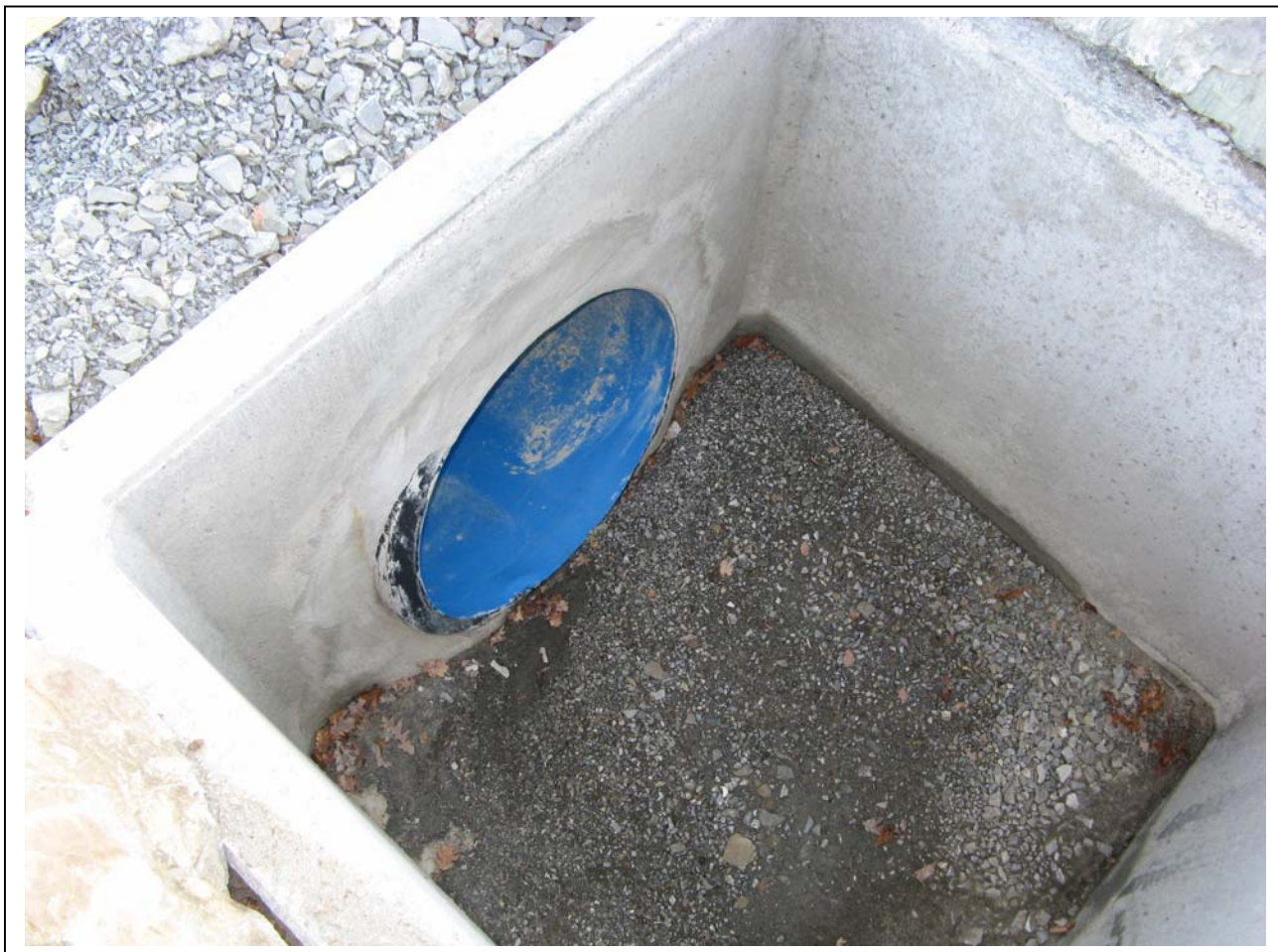
Foto 28 e 29: particolari di pozzetti e passanti sottostrada per lo scolo delle meteoriche
