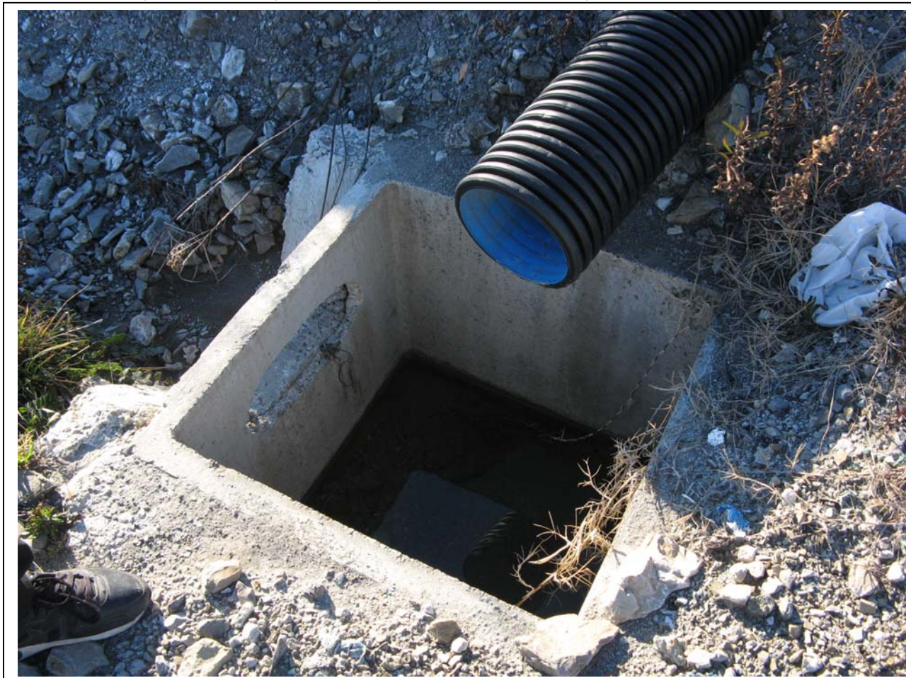
Foto 28 e 29: particolari di pozzetti e passanti sottostrada per lo scolo delle meteoriche
