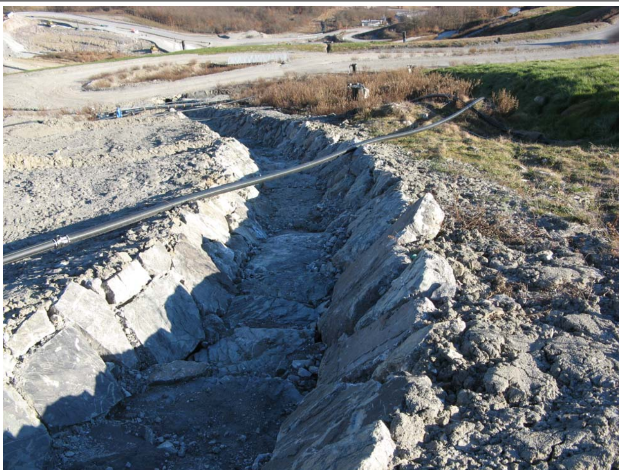
Foto 16 e 17: Particolari della realizzazione dei fossi di scolo principali, con foderatura antierosione del fondo in sasso – fosso posto al confine tra vasca 9down e vasca 7
