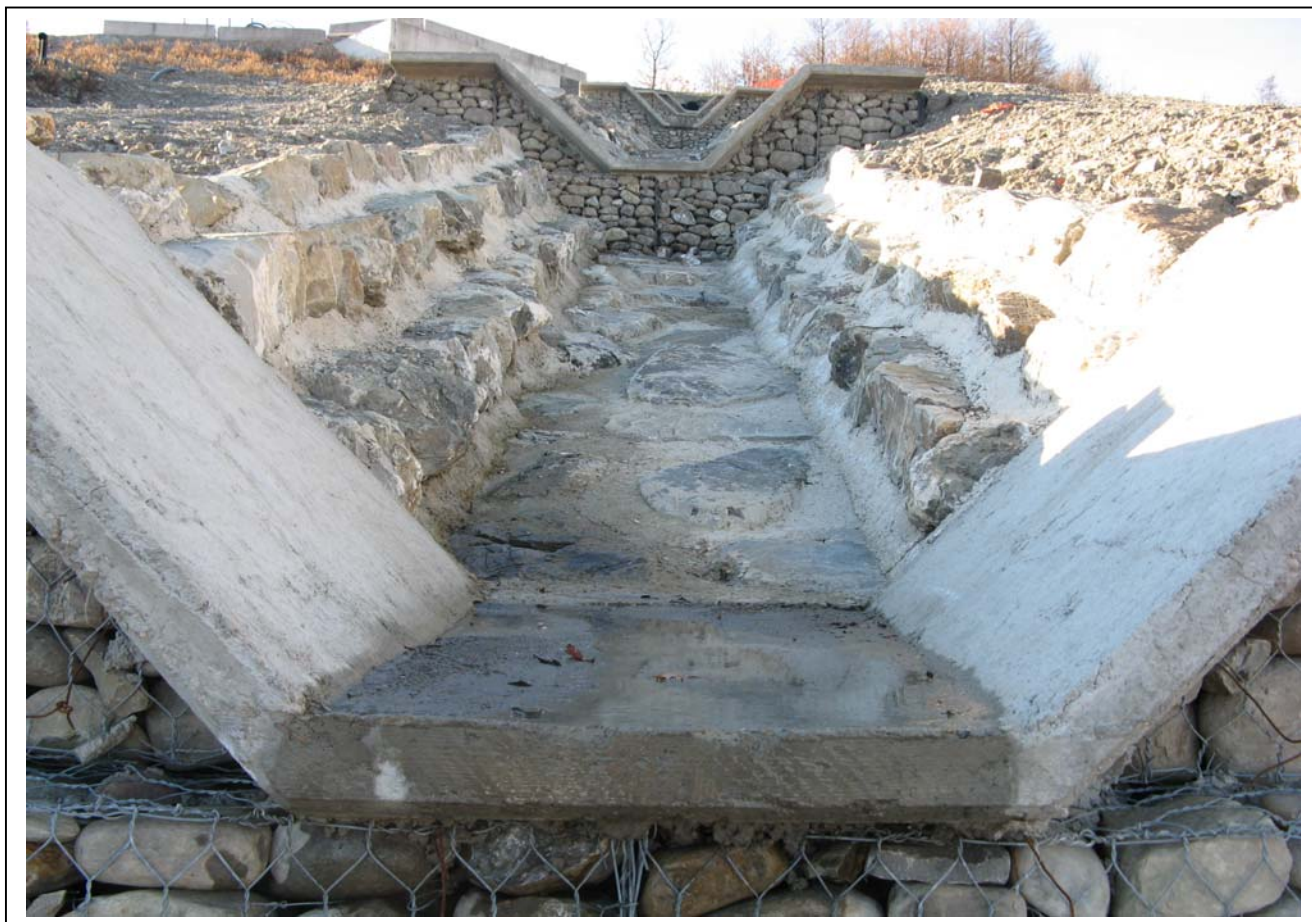
Foto 22: Particolari della realizzazione dei capofosso
