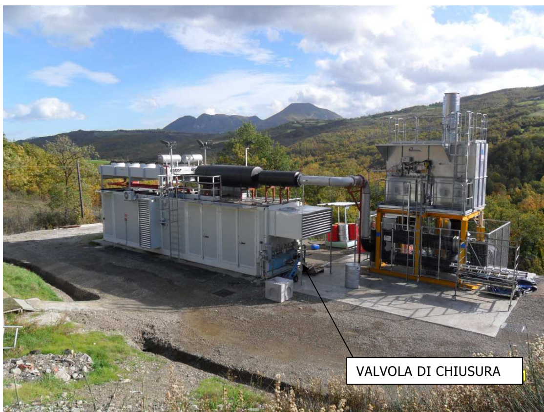
Foto 8: Motore SFLGD 480 Guascor installato presso la discarica di Cà De Ladri
