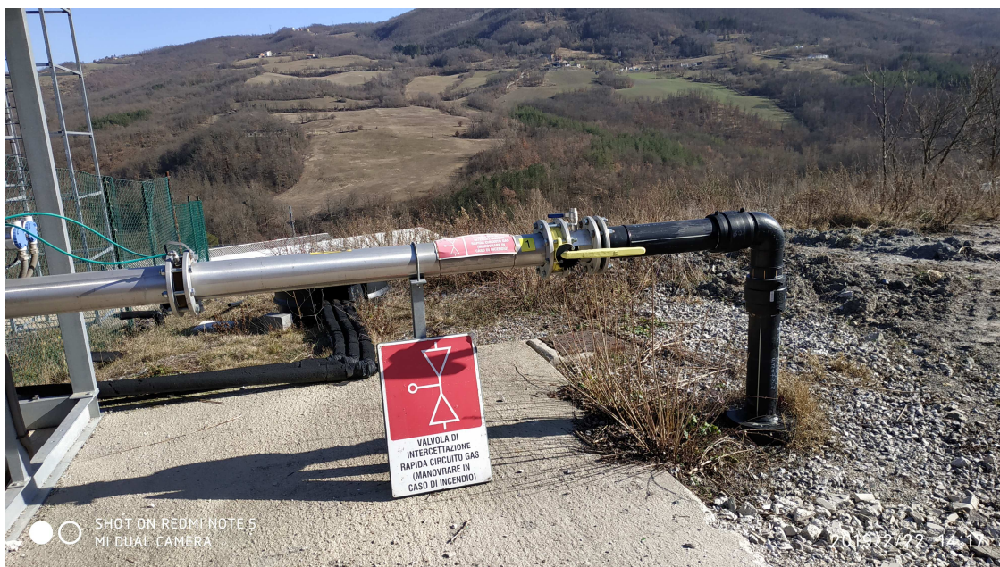
Foto 7: Particolare della valvola di chiusura gas
