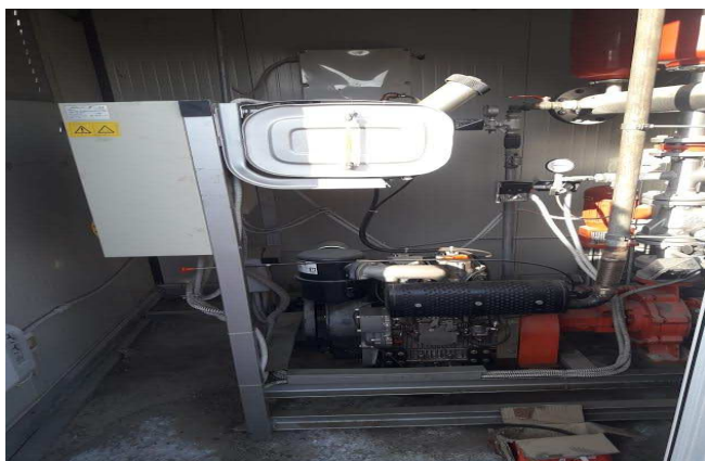
Foto 5 pompa con innesco automatico presente a fianco serbatoi "Torre Faro"
