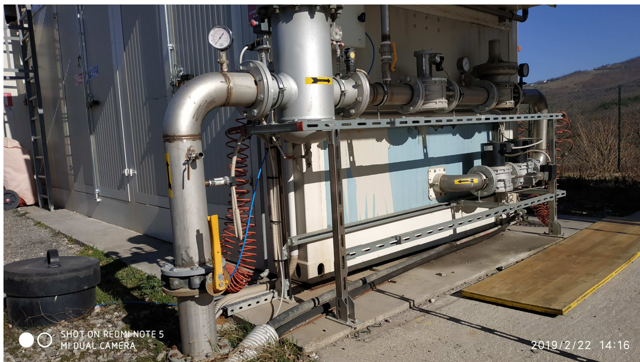
Foto 9: Particolare della valvola di chiusura solo motore
