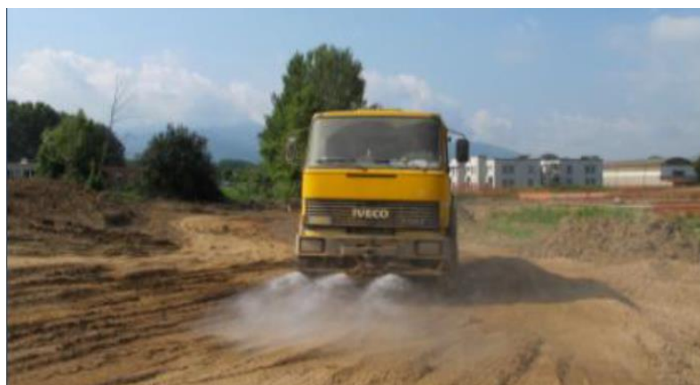
Figura 8: Esempio di bagnatura di piste di cantiere
