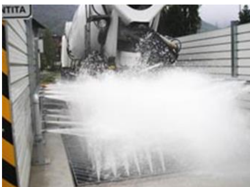
Figura 12: Esempio di sistema di lavaggio delle ruote dei mezzi in uscita dal cantiere
