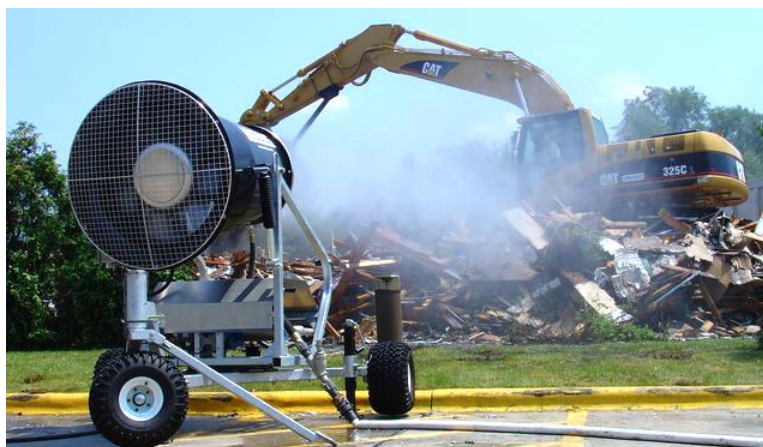
Figura 9: Esempio di sistema di abbattimento polveri con nebulizzatori durante attività di demolizione
