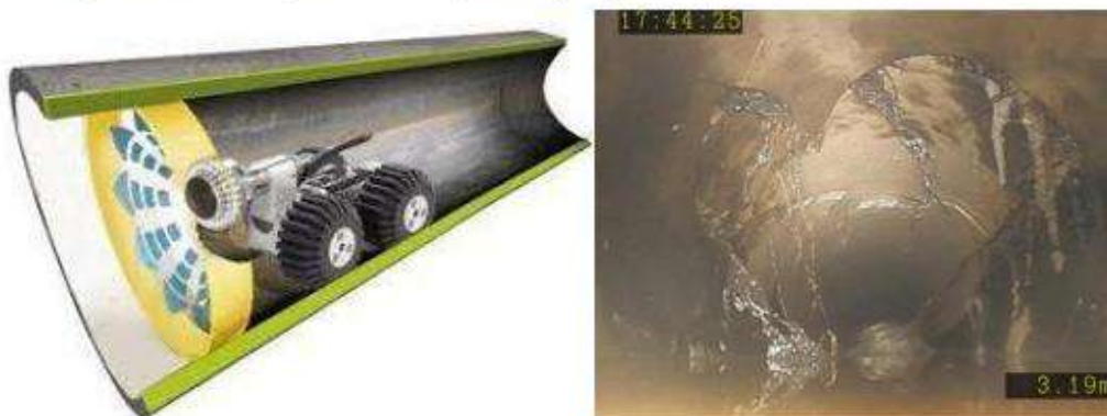
Figura 24 - Esempio di videoispezione per potenziali necessità di risanamento
