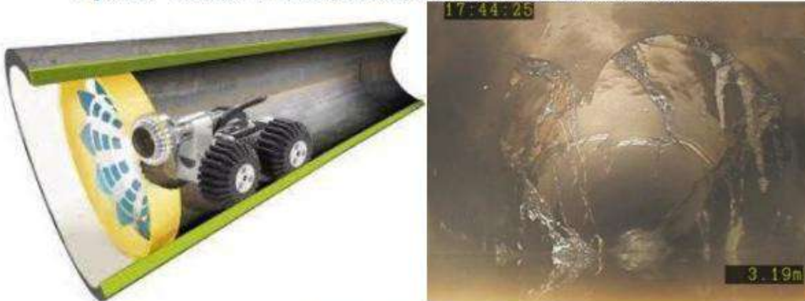
Figura 22 - Esempio di videoispezione per potenziali necessità di risanamento
