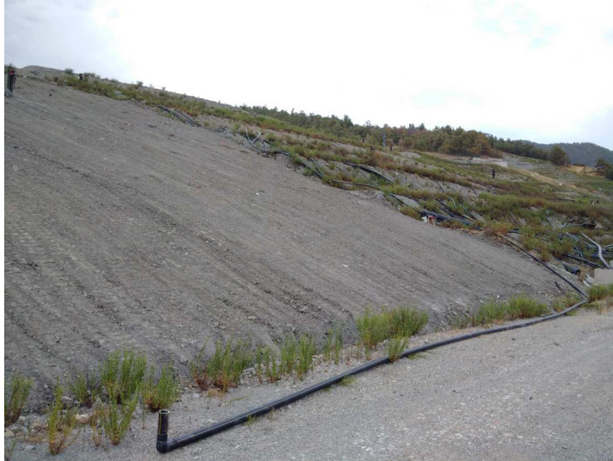
Figura 4: la raccordatura del pendio ed il distacco delle tubazioni di captazione del biogas
