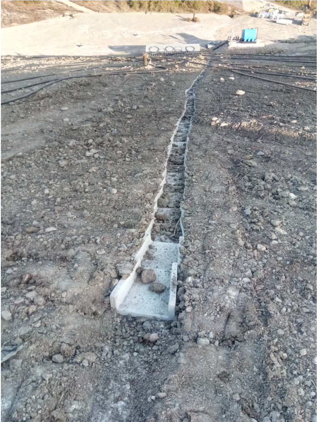
Figura 12: la protezione con embrici in cemento del fosso collettore centrale
