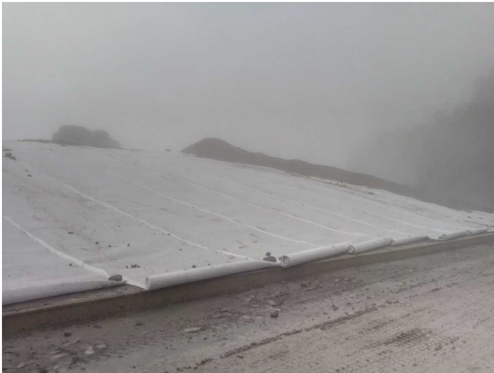
Figura 8: la posa dei teli con sovrapposizione sui bordi per garantire la continuità del manto
