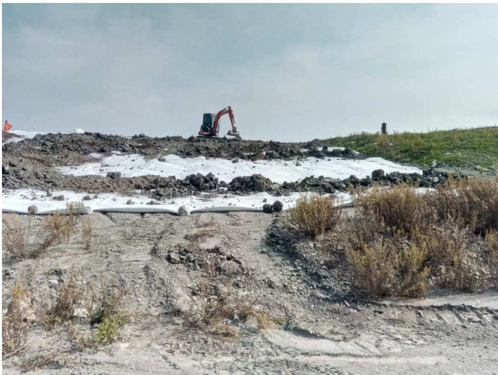
Figura 7: la posa del terreno rinaturalizzato sul telo drenante di separazione
