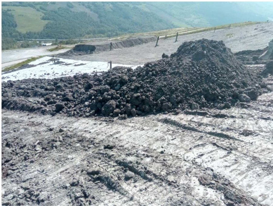
Figura 5: la posa dei teli drenanti per il distacco fra substrato sterile e terreno rinaturalizzato
