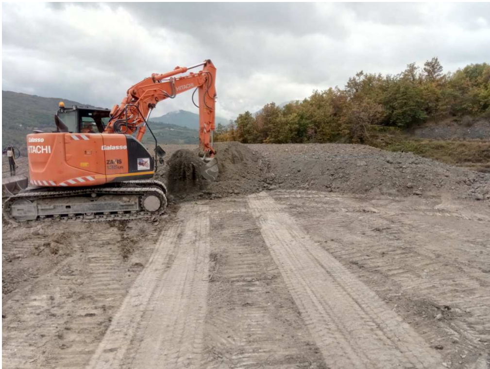
Figura 10: la posa e lavorazione del terreno superficiale rinaturalizzato nello spessore di un metro circa
