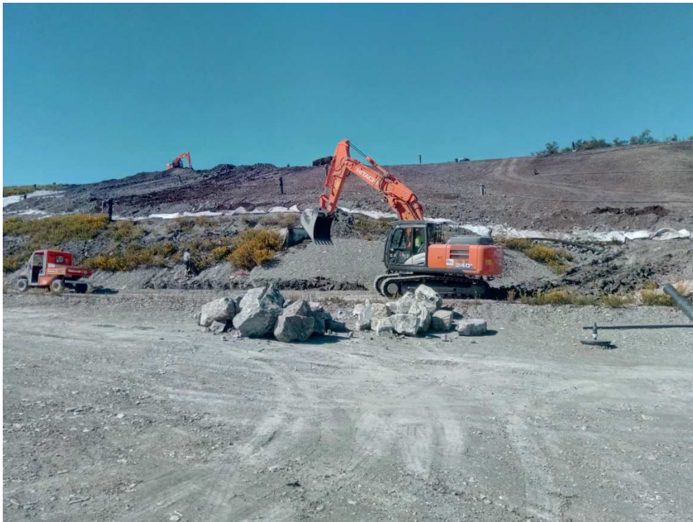
Figura 6: la realizzazione della scogliera di contenimento verticale al piede del pendio
