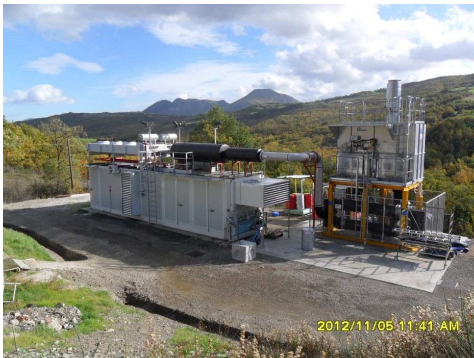
Foto 2: Motore SFLGD 480 Guascor installato presso la discarica di Cà De Ladri
