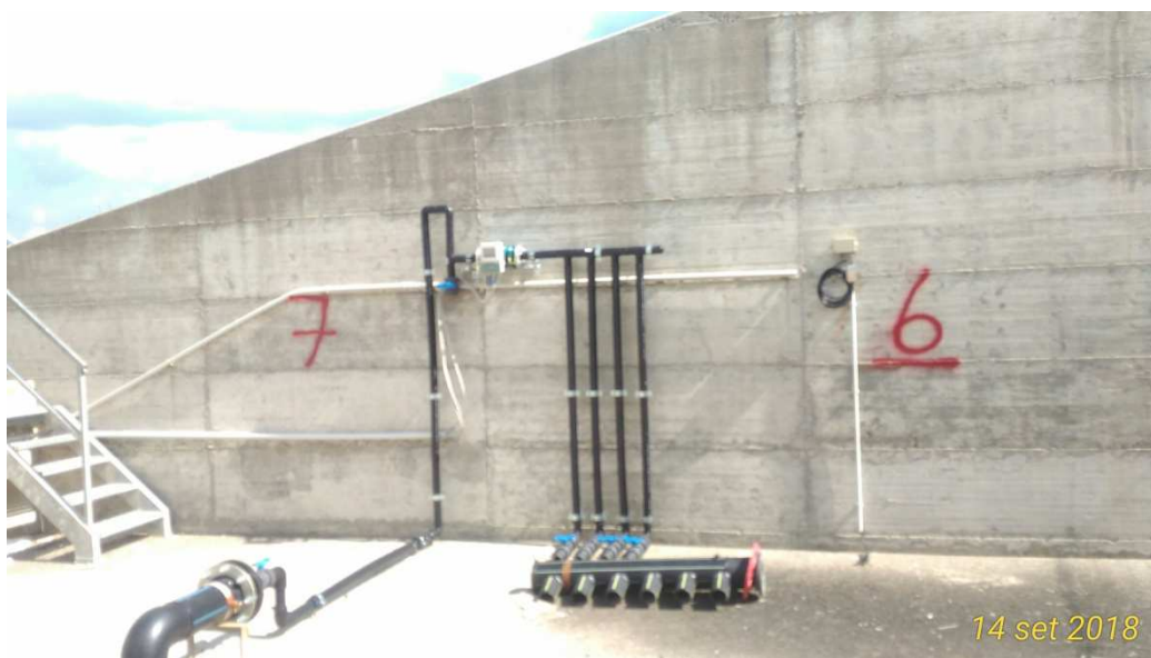
Foto 6: Circuito troppo pieno del serbatoio nr. 8 con misuratore di portata per la quantificazione del percolato smaltito.
