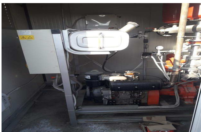
Foto 3 pompa con innesco automatico presente a fianco serbatoi "Torre Faro"
