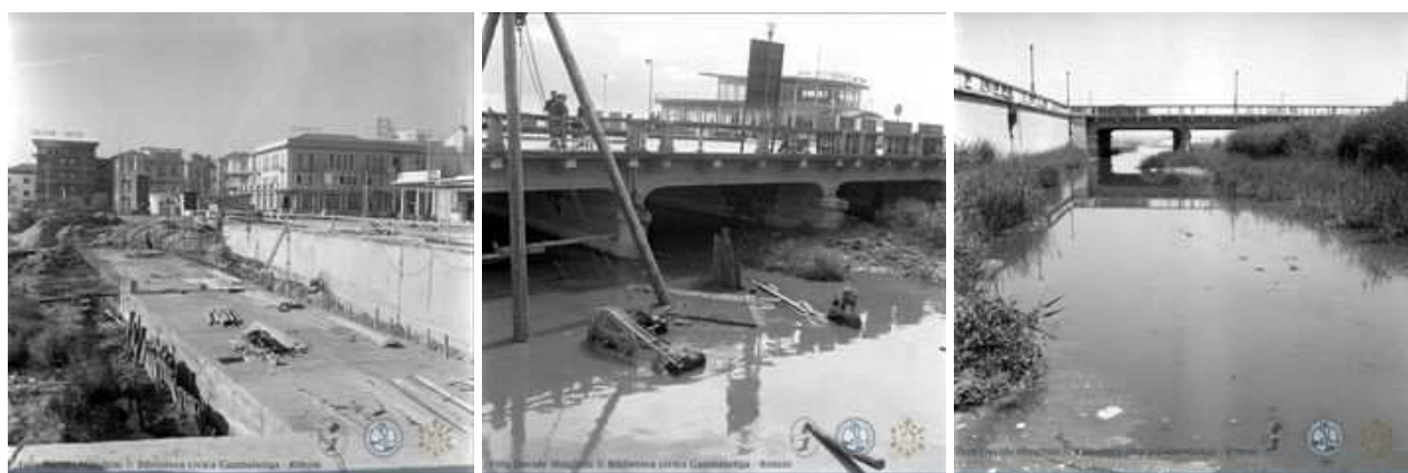
Intervento di tombinatura del torrente Ausa (anni '60) – Muri di sponda e ponte lungomare da demolire
