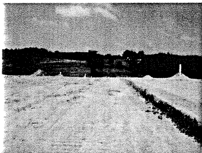
Livellamento superficie e trincee di drenaggio
