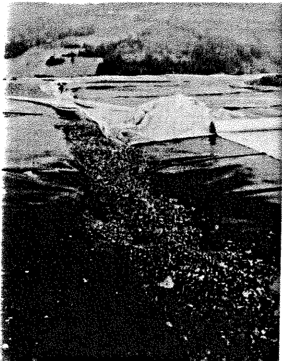
Solco di drenaggio con telo HDPE tubo forato e ghiaietto
