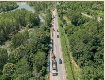
SMAT. Posa delle condotte per l'Acquedotto della Valle Orco
