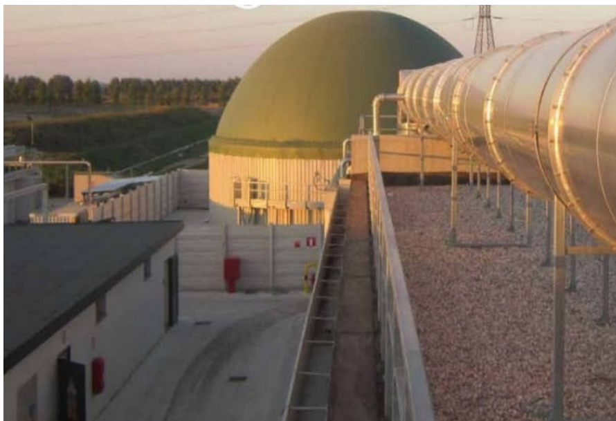
Figura 6: Digestore Anaerobico.
