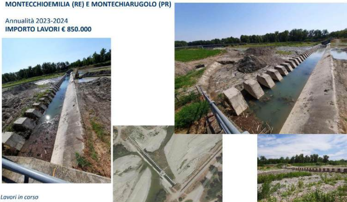
Figura 82 – Lavori di manutenzione straordinaria dei manufatti al servizio delle casse di espansione sul t. Enza (fonte: AIPo) – 3 di 3
