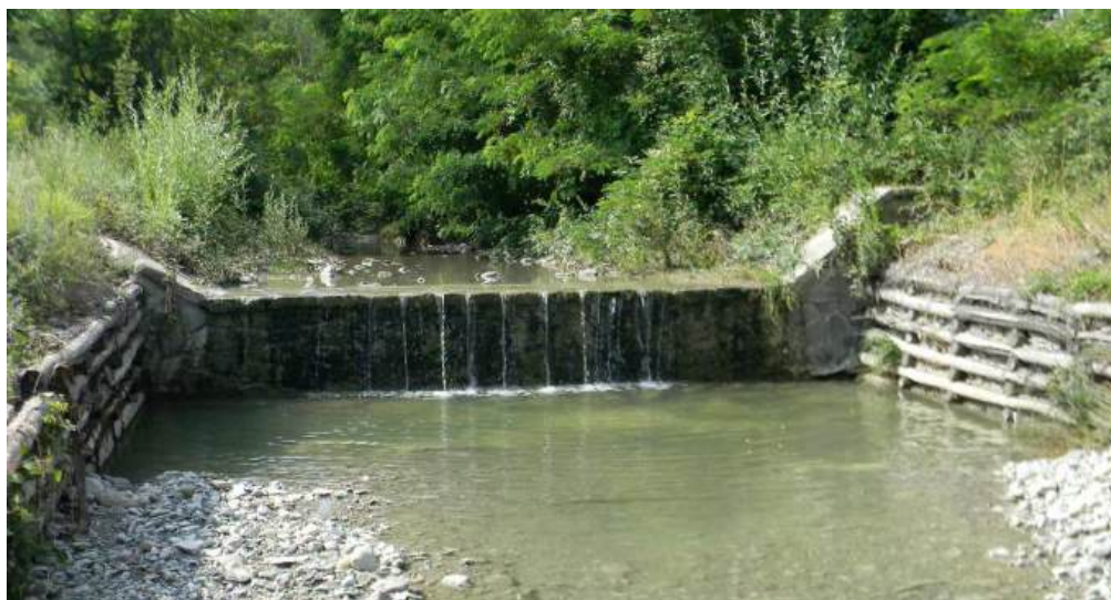
Figura 65 – Esempio di briglia trasversale che interrompe la continuità su un piccolo corso d'acqua nel Sito Natura 2000 “Rupe di Campotrera Rossena” (fonte: Quadro Conoscitivo delle Misure Specifiche di Conservazione)
