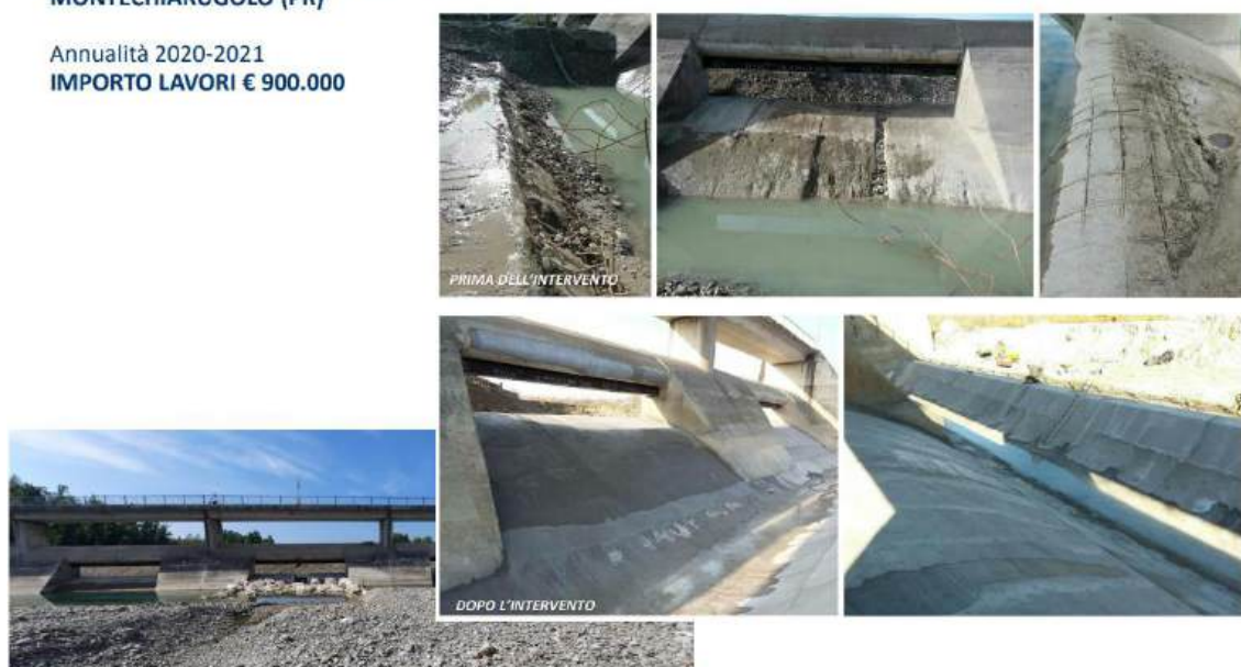
Figura 80 – Lavori di manutenzione straordinaria dei manufatti al servizio delle casse di espansione sul t. Enza (fonte: AIPo) – 1 di 3
